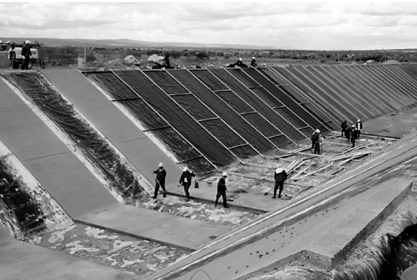
Concretagem de trecho do canal do Projeto de Integração do Rio São Francisco Foto: Ministério do Planejamento/Divulgação
