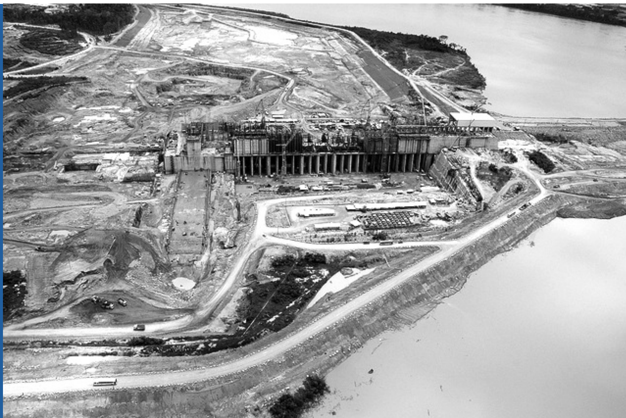
Obras da Usina Hidrelétrica Jirau, no Rio Madeira, em Rondônia Foto: Ministério do Planejamento/Divulgação
