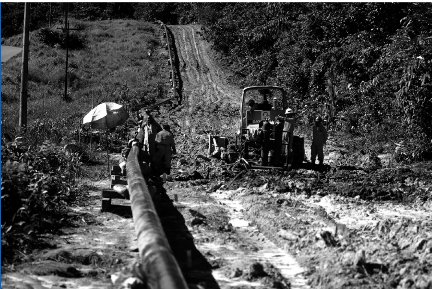
Obra do Gasoduto Urucu-Coari-Manaus, no Amazonas Foto: Alberto César Araújo/Amazônia Real
