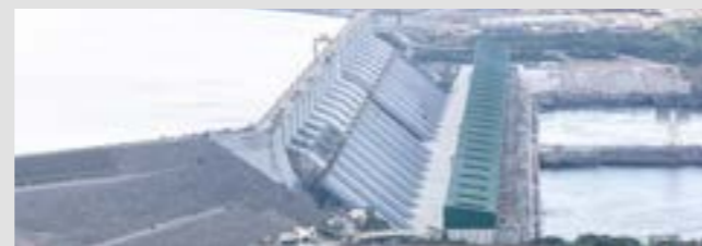
HIDRELÉTRICA DE BELO MONTE (PARÁ)
