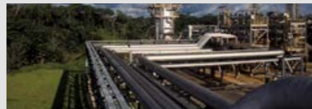
GASODUTO URUCU-COARI-MANAUS (AMAZONAS)
